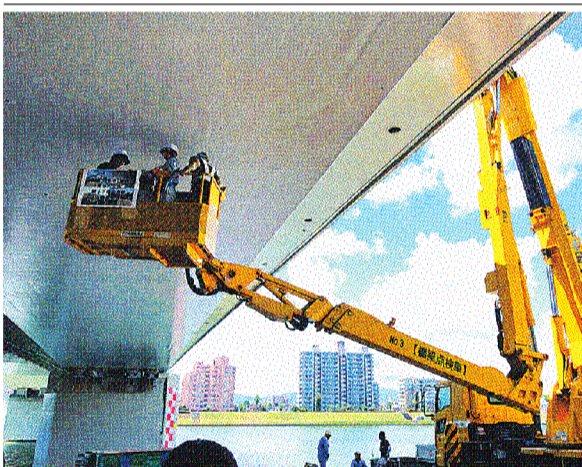
橋の点検作業見学(体験)会【国道220号「橋橋」】
