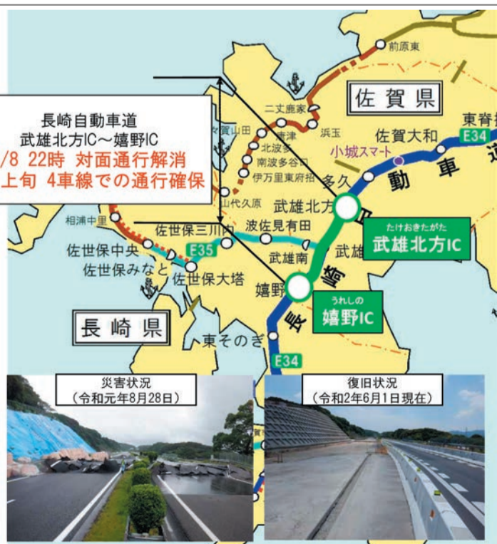
災害状況（令和元年8月28日） 復旧状況（令和2年6月1日現在）
