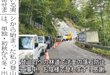
登山口への林道で法面の落石防止工事中。お陰様で登れます!感謝。
