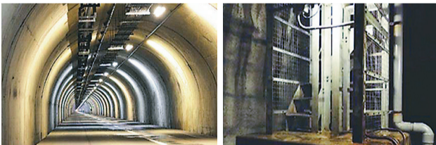
関越トンネル 避難坑 関越トンネル 立坑階段
