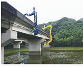
橋梁点検車の活用
