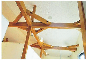
斜材の補強による建物の耐震化対策
