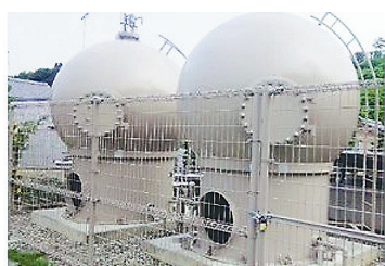
貯水タンクの整備
