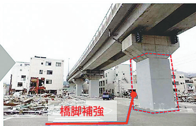
東日本大震災における耐震補強の効果(国道45号釜石高架橋)
